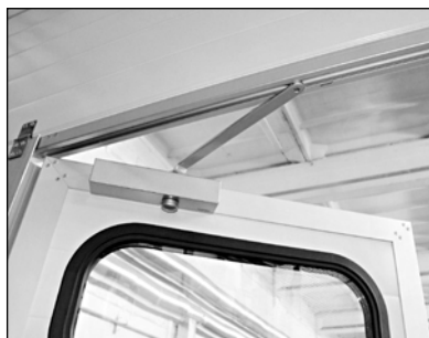
Рис. 44а. Установка доводчика. Калитка открыта
