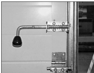
Рис. 41. Установка засова. Положение "открыто"
