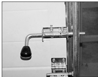
Рис. 41а. Установка засова. Положение "заперто"
